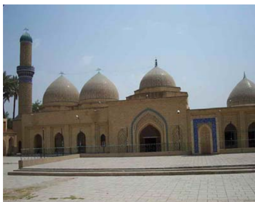
آرامگاه سلمان فارسی در جنوب بغداد
